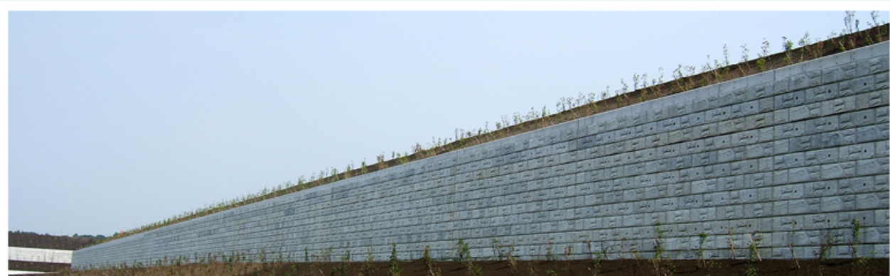
静岡県 工業団地造成（総延長700m以上、擁壁面積6,000㎡以上）
