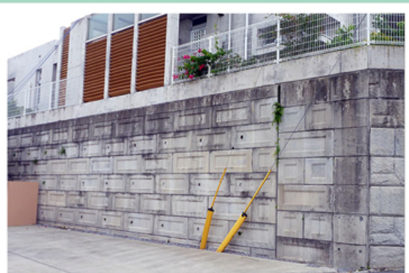
沖縄県 住宅地造成
