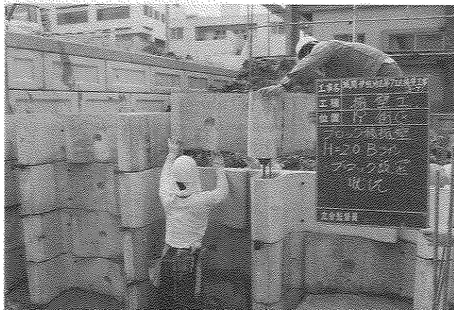
写真-4 ブロック据付け(2段目)
